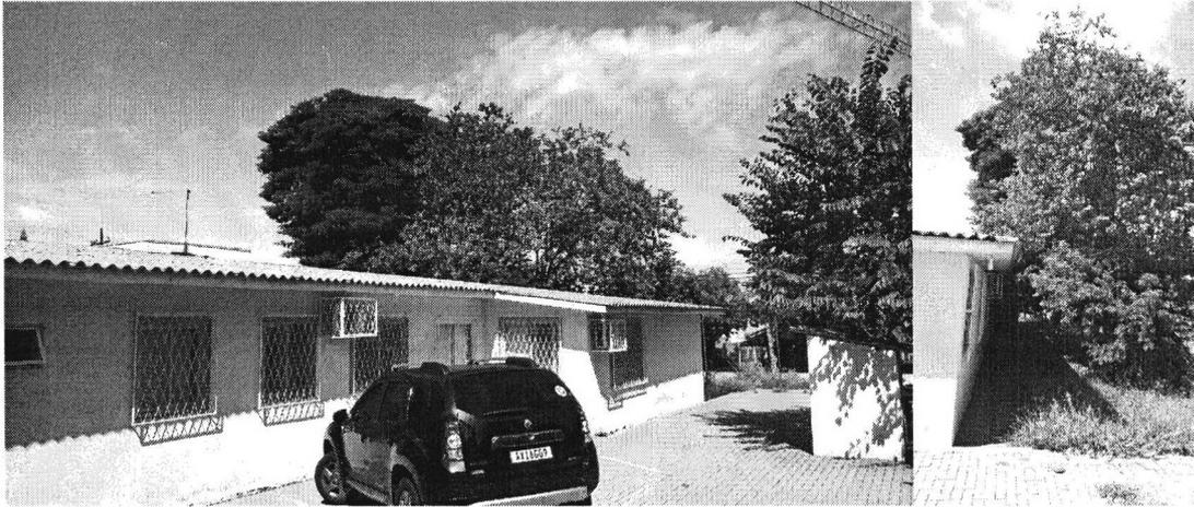
Calhas entupidas por conta das árvores provocam infiltrações e goteiras na unidade
